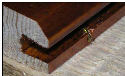
Detail hotového spoje
